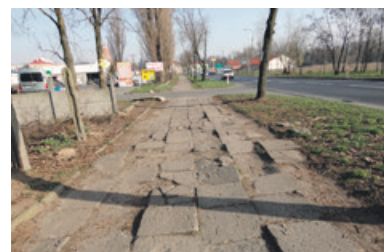
Remont DK91 obejmie jedynie półkilometrowy odcinek
