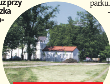
Polna droga do parku – od strony basenów – jest w fatalnym stanie
