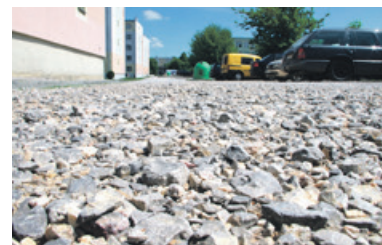
Wylanie asfaltu zaplanowane jest na przyszły rok
