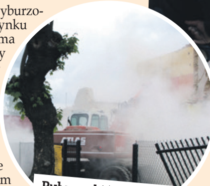
Pył z rozbiórki spowił ulicę i okoliczne budynki
