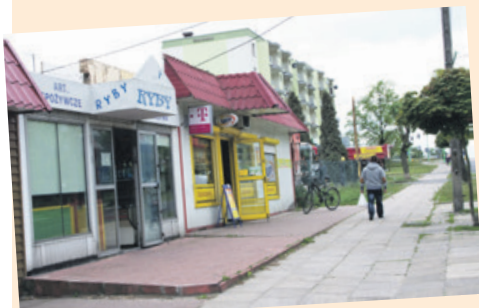
Pawilony nie będą wyburzane – usłyszeliśmy od inwestora
