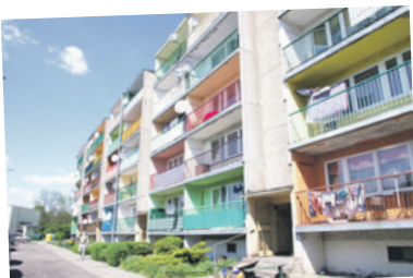
Remont obejmie również renowację balkonów
