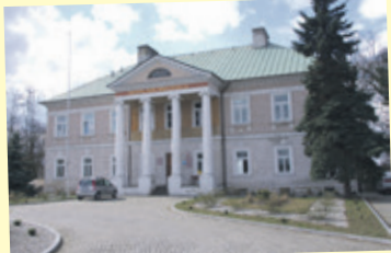
Siedzibą władz jest pałac, który wymaga remontu
