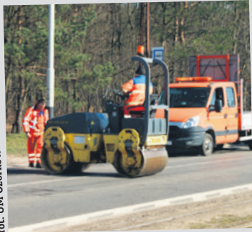
Uzupełnianie ubytków w jezdniach na ul. Zgierskiej
