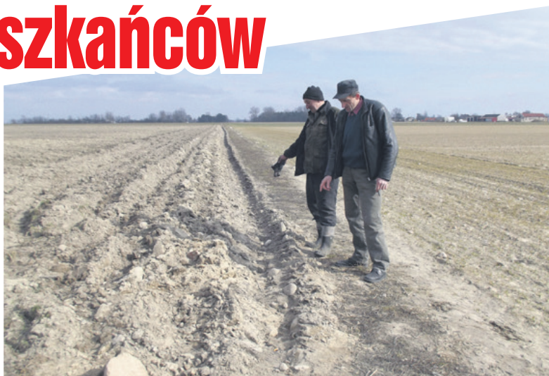
Rolnicy pokazują zaoraną część drogi gminnej
