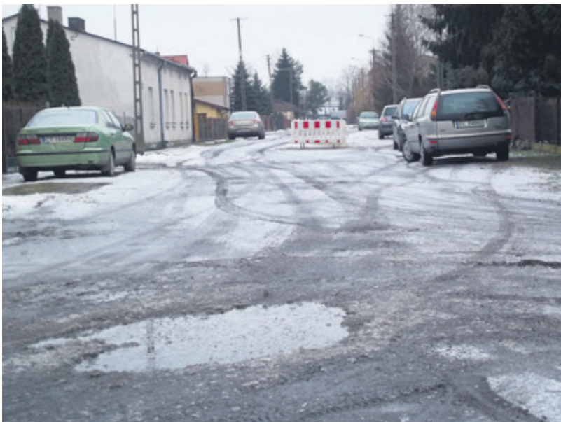
Czy ul. Dworzaczka zostanie w tym roku wyremontowana?
