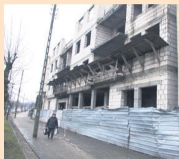
Ruina stoi przy ul. Wyszyńskiego
