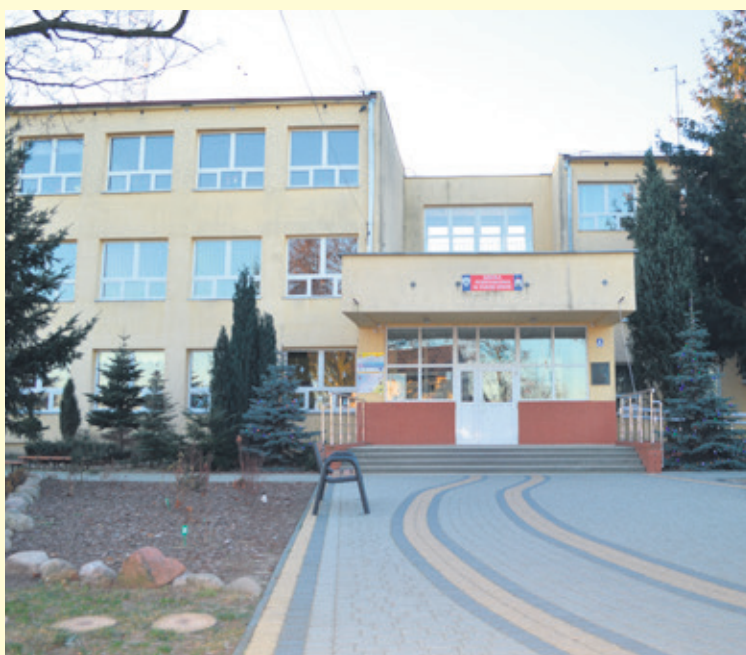
Planowana do rozbudowy Szkoła i Punkt Przedszkolny w Parzęczewie
