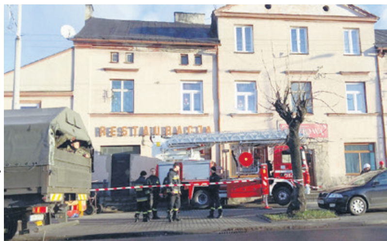
Strażacy zabezpieczyli sypiącą się kamienicę
