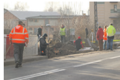
W piątek ruszyła przebudowa drogi wewnętrznej
