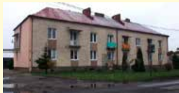
Budynek czeka gruntowny remont
