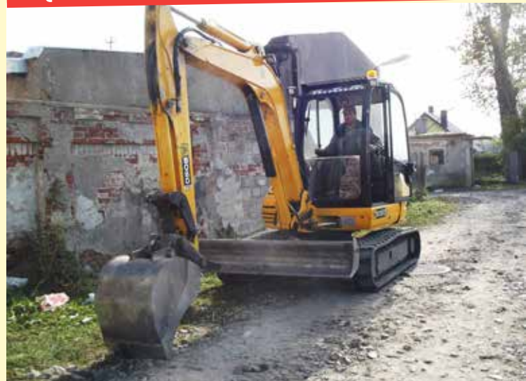
W czwartek rozpoczęto przygotowanie drogi do układania płyt chodnikowych
