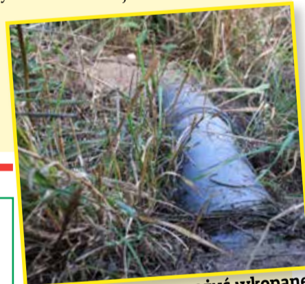
W ziemi łatwo zauważyć wkopane rury, którymi tłoczone są ścieki
