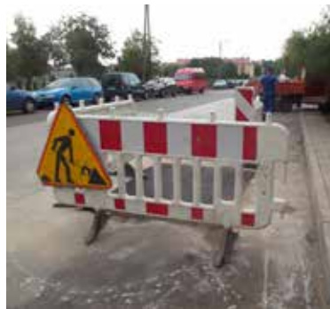
W tym miejscu pracownicy PGKiM-u odkopali starą studnię
