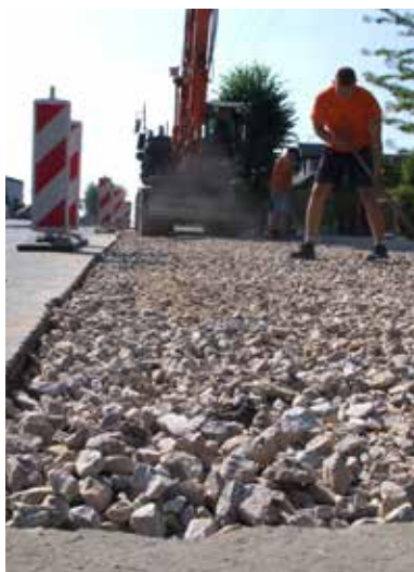
Robotnicy położyli kamienną podbudowę asfaltu
