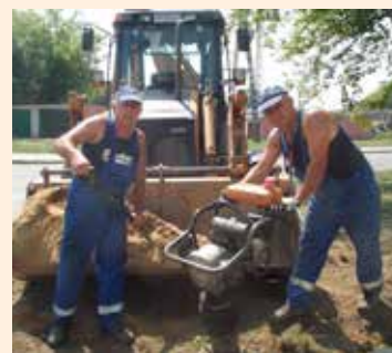
Pracownicy sprawdzają czy hydranty nie są uszkodzone
