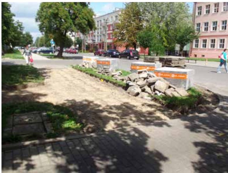
Stare płyty zostały zdemontowane, przejście było utrudnione
