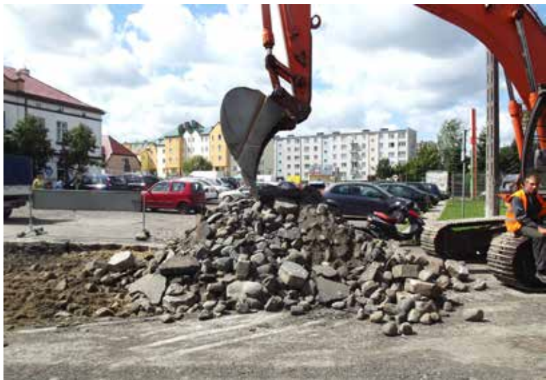
Remont drogi potrwa do końca października
