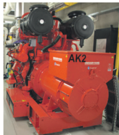
Potężne agregaty prądotwórcze
