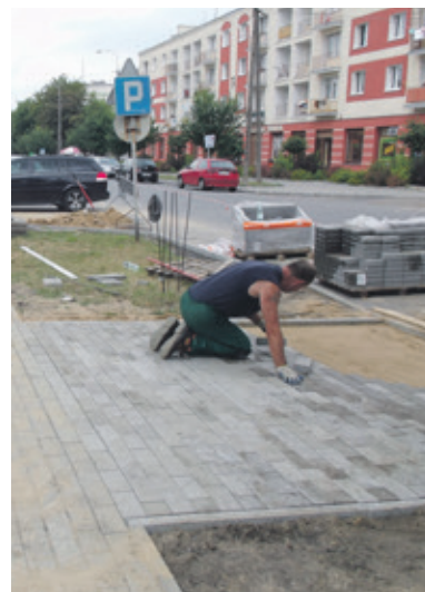
W miejsce starych, nierównych płyt kładziona jest kostka
