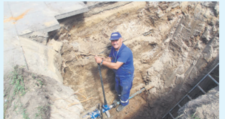
Pracownicy PGKiM szybko wymienili przyłącze wody
