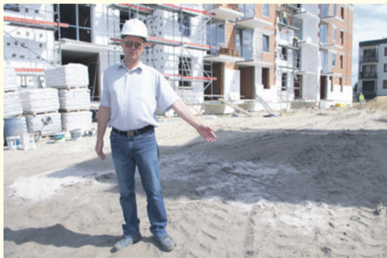
Kierownik budowy pokazuje w którym miejscu będzie fontanna
