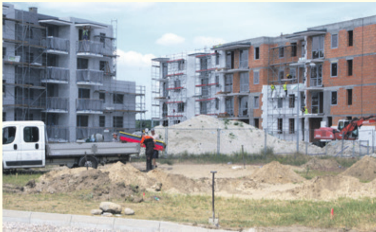
Pomału dobiega końca budowa bloków przy ul. Reymonta i Targowej
