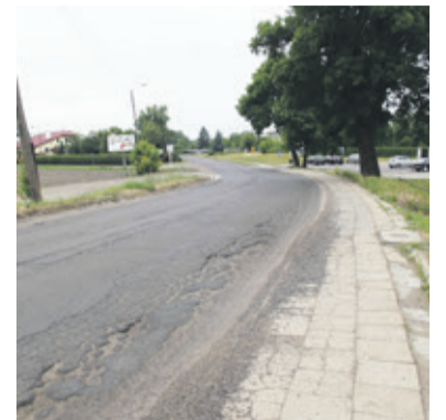
Ulica Lotnicza niedługo zostanie wyremontowana
