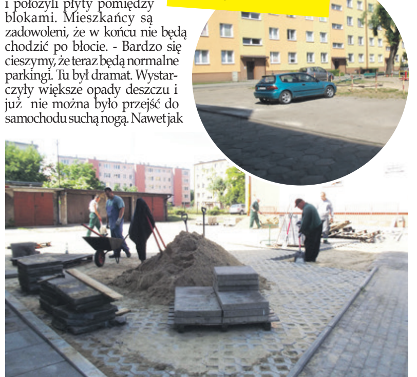
W ubiegłym tygodniu pracownicy kończyli prace przy Zachodniej 25
