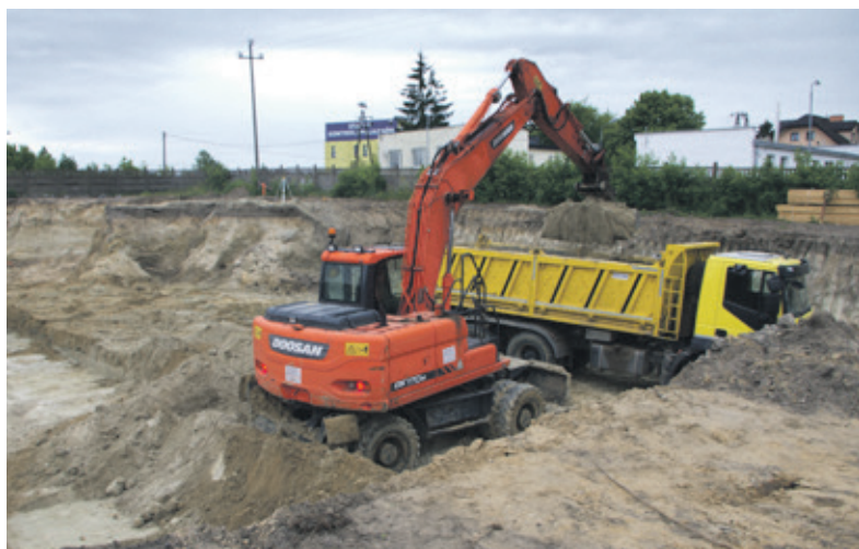
Przy ul. Targowej budowana jest komenda policji
