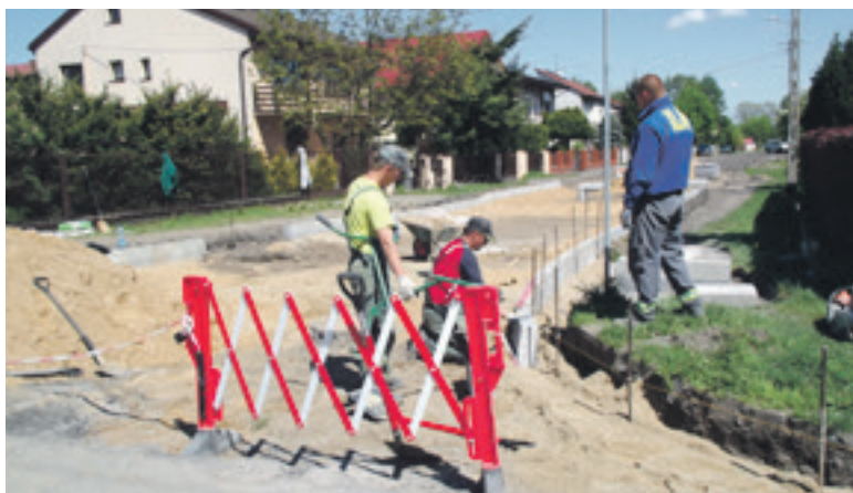
Póki co, rozkopana jest połowa ulicy Norwida. Kostkę brukową na Waliszewie układają pracownicy ZM
