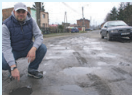
Mieszkańcy już niedługo nie będą się skarżyć na dziury w ul. Malinowej
