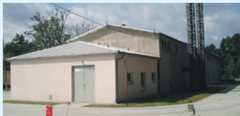
Kotłownia w Mazewie
