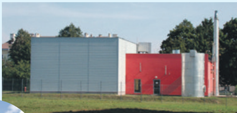
Kotłownia w Daszynie
