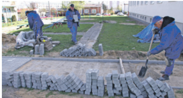
Na osiedlu przy Staszica rozpoczęła się oczekiwana przez mieszkańców inwestycja
