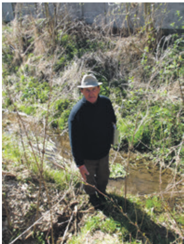
Rów melioracyjny jest w bardzo złym stanie
