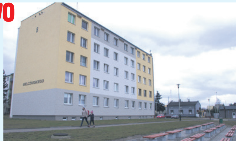
Na dachu tego bloku mają zostać zainstalowane nowocześniejsze kamery
