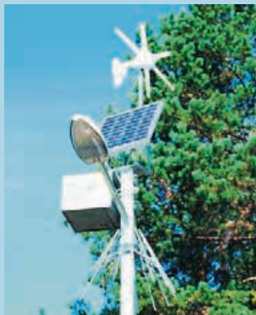
Lampa z ogniwem fotowoltaicznym w Daszynie
