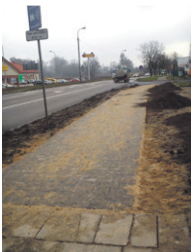
Chodnik przy dworcu autobusowym
