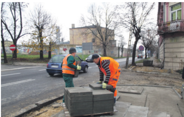
Wymiana płyt przy DK91
