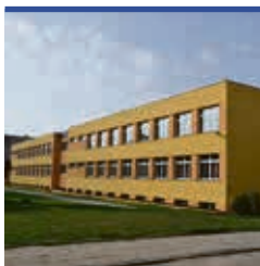
Termomodernizacja SP nr 4
