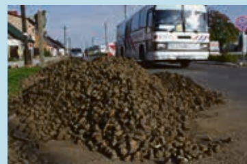
Kierowcy, w związku z remontem, muszą uważać na drodze
