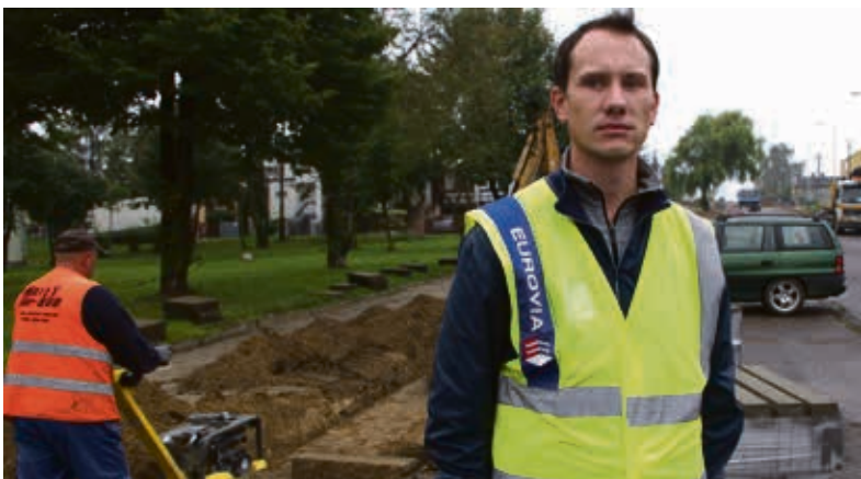
Inwestycji parkingowej nie mamy w projekcie - mówi kierownik robót
