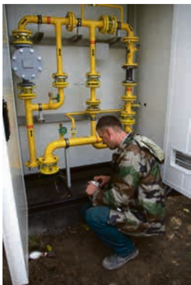
W czwartek, przy kotłowni w Mazewie, zainstalowana została stacja redukcyjno-pomiarowa
