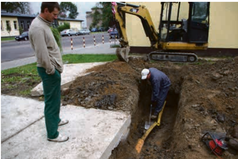
Gazowe przyłącze do kotłowni. Prace zakończą się w ciągu kilku dni
