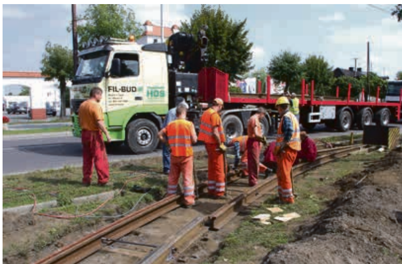
Remont torowiska trwał przez cały dzień
