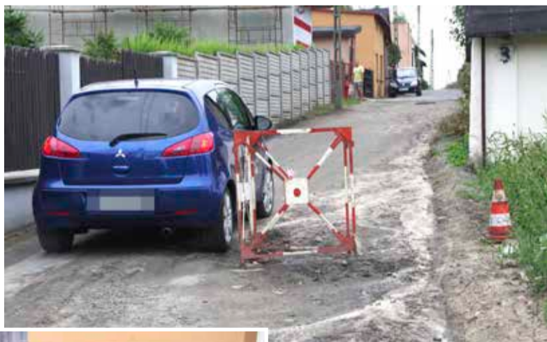
Samochody mijają konstrukcję zaledwie o centymetry
