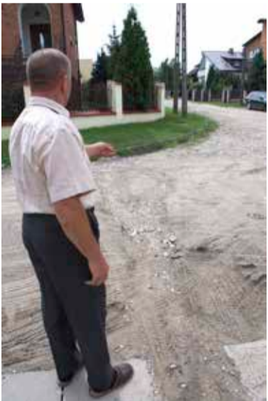
Po opadach woda sływa od strony ul. Łącznej
