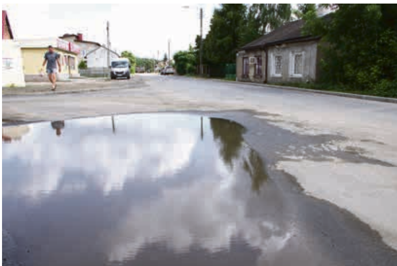
Ogromna kałuża na zmodernizowanej ul. Zagajnikowej
