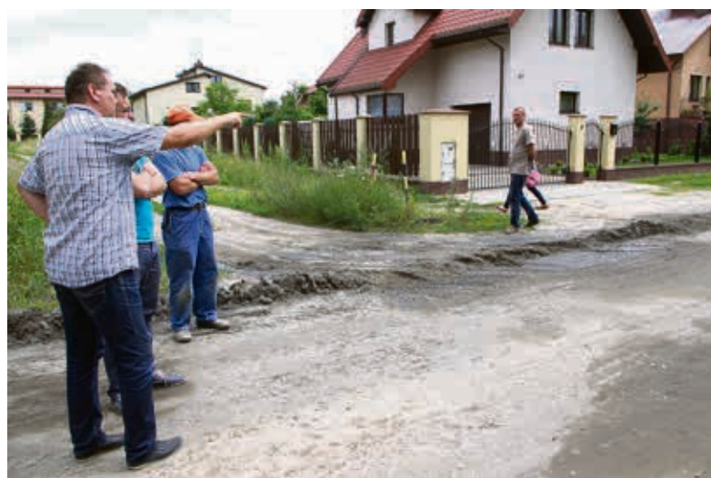
Na Cichą i Cmentarną przyjechali wykonawcy remontu
