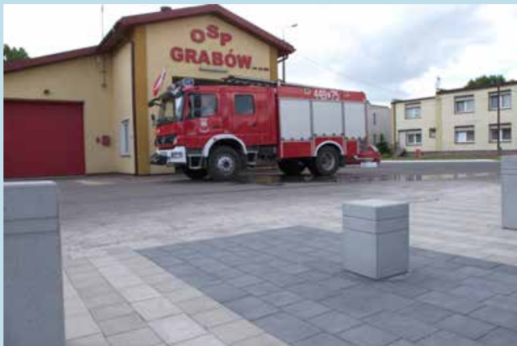
Przed remizą stoją na wyremontowanym placu betonowe słupki
