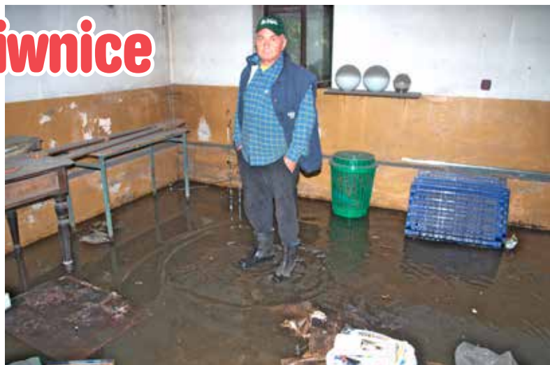
Stanisław Fabich w zalanej piwnicy domu
