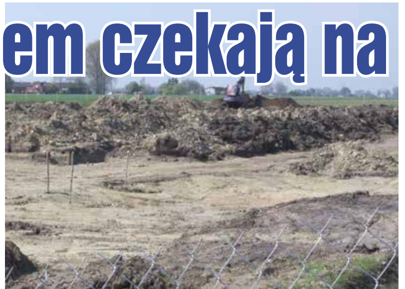
Rozpoczęła się budowa zakładu. Prace mają potrwać do września
