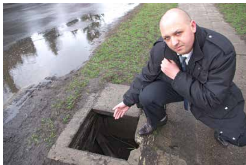
Tomasz Gabrysiak pokazuje niezabezpieczoną studzienkę
