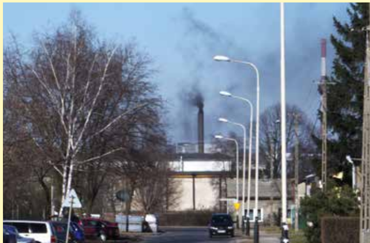
Z komina kotłowni mleczarni wydobywają się kłęby czarnego dymu
