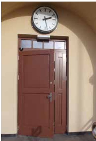
Od kilku dni do budynku dworca można dostać się jedynie wejściem dla niepełnosprawnych
