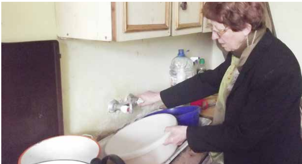
W kranie sucho... Pani Barbara, pomimo spartańskich warunków w kamienicy, nie przyjęła lokalu socjalnego zaproponowanego przez miasto
