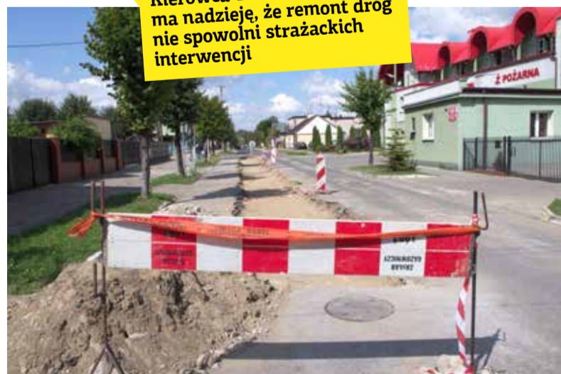
Na razie jeden pas drogi został wyłączony z ruchu
