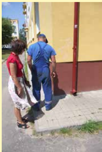
Kontrola wykonanych prac, czyli zamurowania rur spustowych
