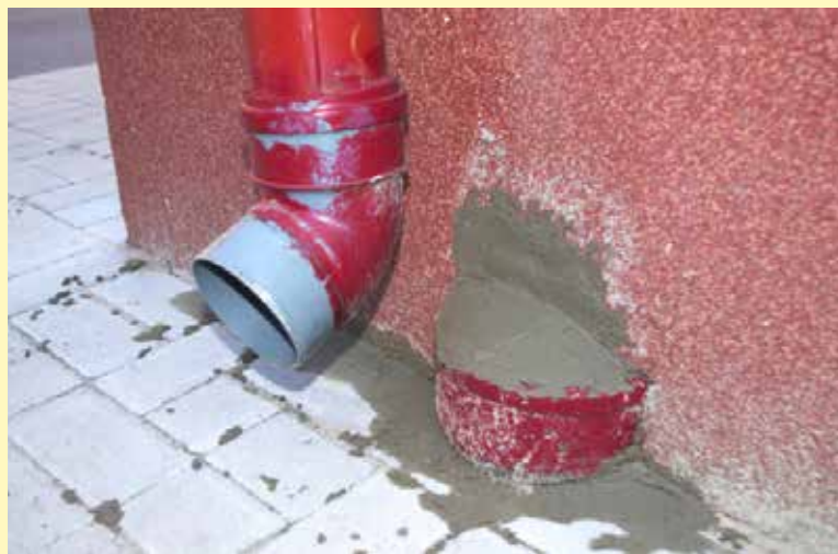
Teraz woda po opadach deszczu zamiast do spustu spłynie wprost na chodnik
