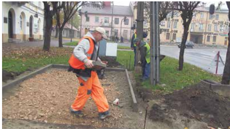
Trwa budowa parkingów przy muzeum w Krośniewicach
