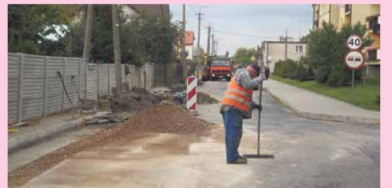
Łódzki Zakład Gazowniczy układa gazociąg w ulicy Armii Krajowej w Gostyninie. Wybudowanych zostanie ok. 205 metrów gazociągu, aż do przychodni „Medicusa”. Zrobione zostanie również przyłącze do przychodni.
