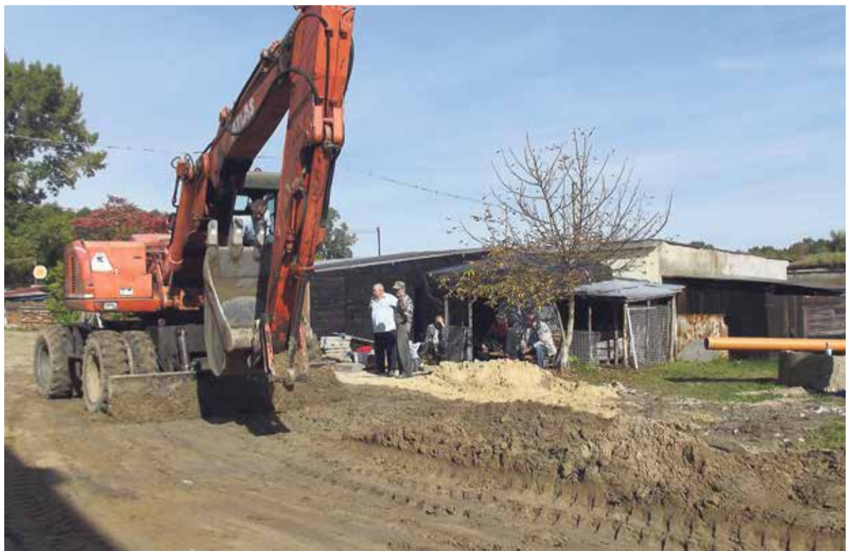
Nowa sieć kanalizacyjna jest układana przy budynkach dawnego PGR w Sokołowie
