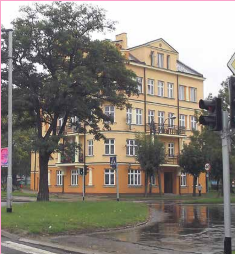
Niedawno zakończył się remont zabytkowej kamienicy przy ul. Warszawskie Przedmieście w Kutnie
