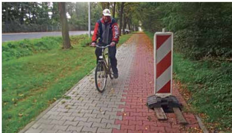
Kratkę od studzienki zabrano ze ścieżki rowerowej z Gostynina do Legardy. Miejsce jest zabezpieczone.
