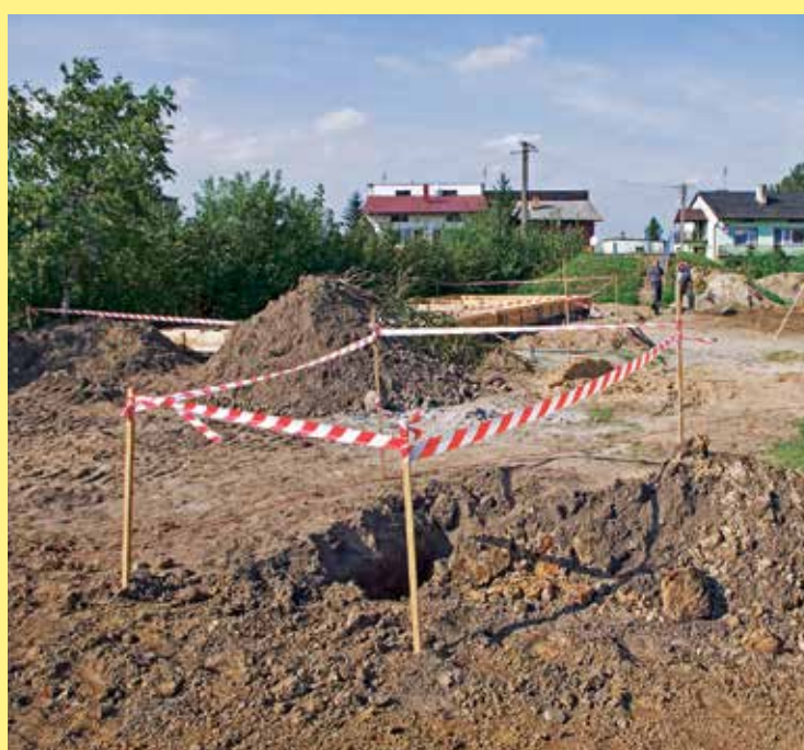
W podobnym wykopie pracował poszkodowany robotnik
