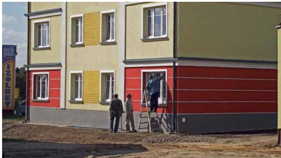
Budowa 2 budynków komunalnych dobiegła końca
