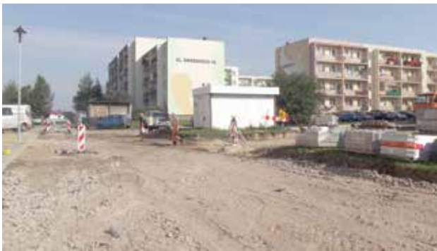
Trwają prace przy budowie parkingu przy ul. Sikorskiego
